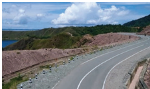
Pembangunan jalan Trans Papua Barat
